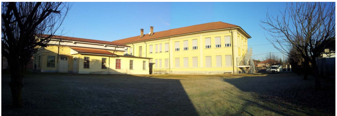
Foto n.1 - Vista d'insieme dell'area di interesse
